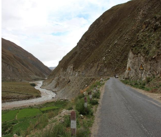
尼木玛曲及 102 县道（输水线路附近）
